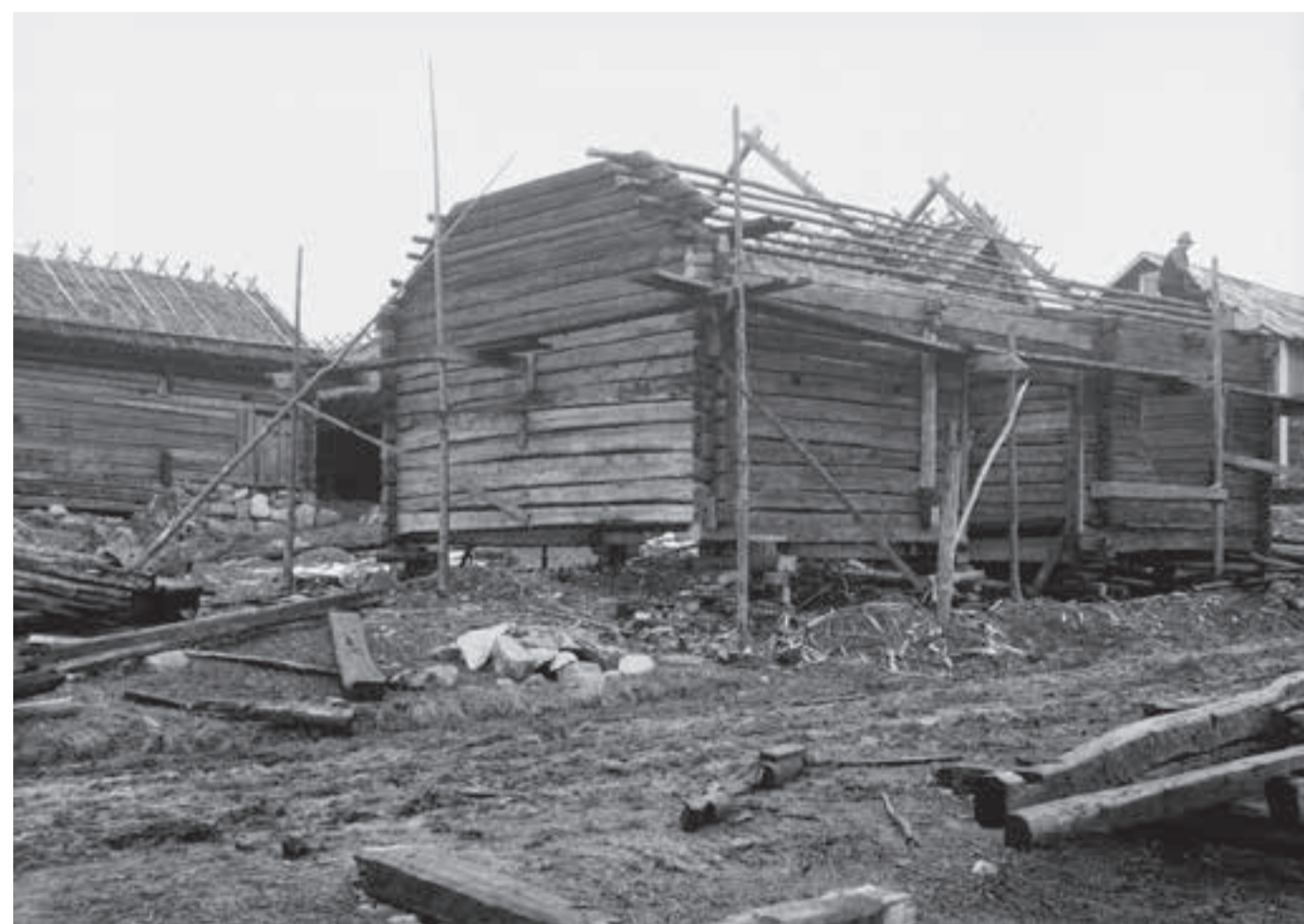
Restaureringen. Efter att Sydvästra Upplands hembygdsgille förvärvat gården i Kvek 1932 restaurerades gården och invigdes till museum 1934. Museimannen Nils Alenius ledde restaureringsarbetet som skedde efter den tidens principer, där stor hänsyn togs till gårdens autenticitet. Samtliga byggnader monterades ned, grunderna förstärktes och timrades sedan upp igen. Ersättningstimmer togs från gårdens stora lada från 1820-talet, som revs. I dess ställe reste man en mindre lada som flyttades från Högstena by i Biskopskulla.
