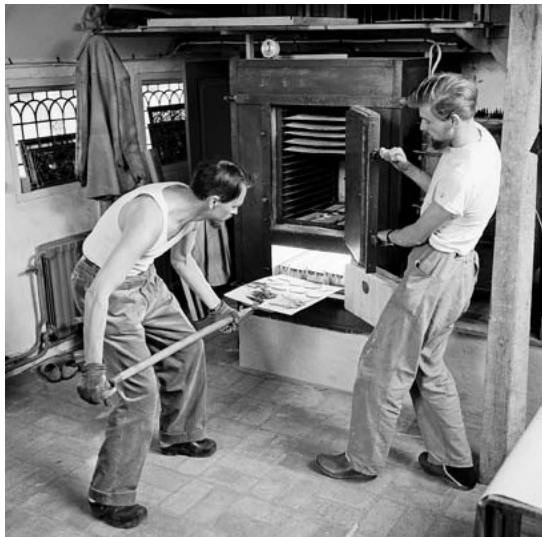
FIGUR 10. Ralph Bergholtz, klädd i manchesterbyxor, träschor och vitt linne, lyfter in en plåt med glas i ugnens tusengradiga hetta på Glasverkstan. Assistenten Torsten Anjou håller ugnsluckan. Fotot togs av Georg Oddner för ett reportage i Idun 1952. FOTO: Georg Oddner, Malmö museer, GO 195205/100.
