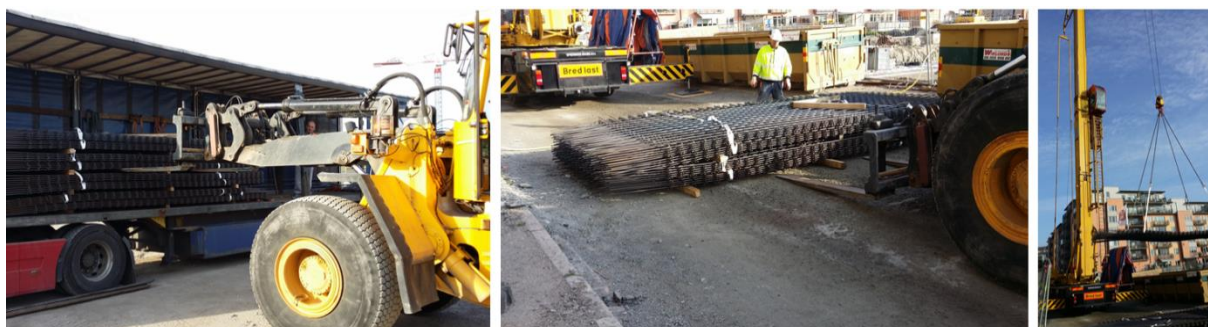
Figur 1 Leverans av armeringsnät som lyfts fram till lyftkranen och används direkt.
