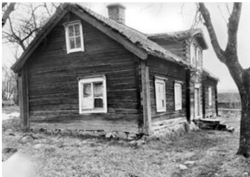
Fig. 7:9. Parstuga i Viggeby by, Biskopskulla socken, av den modell om blev vanligare under 1800-talet. Den är högre och bredare och längre, har inredda vindsrum, rödfärgade fasader och bräd- eller tegeltak. Jämför med parstugan i Kveks by i fig. 7:7. Foto: P Sandberg, Upplandsmuseet RR 650.
