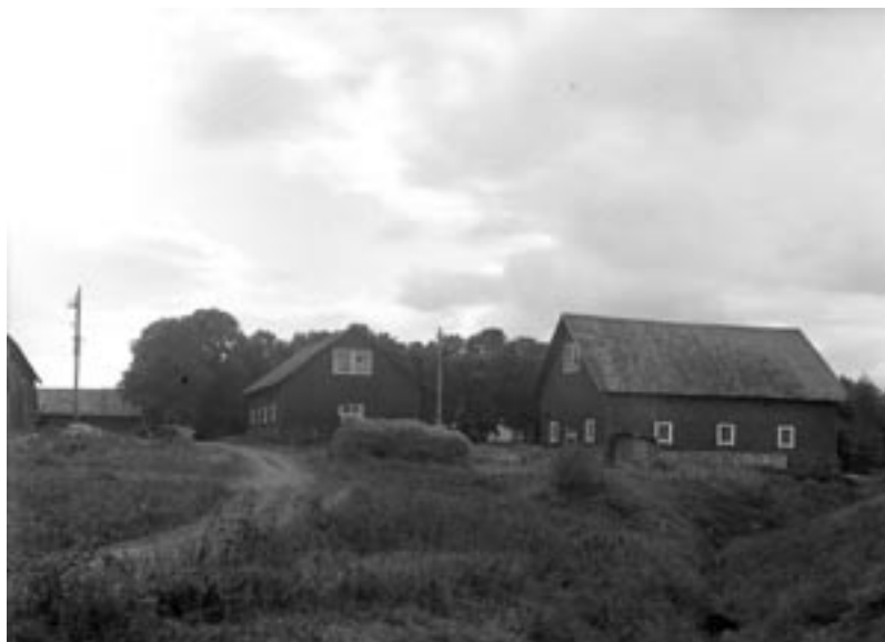
Fig. 55. Ekonomibygnader på Husby gård, Gryta socken. I centrum av bilden ligger den gamla ladugårdsplatsen på gården, vilken till delar utrymdes mot slutet av 1800-talet då de nya byggnaderna inte fick plats. På den gamla ladugårdstomten ligger endast två fähus kvar uppförda på 1870-talet, men nu omvandlade till stall och oxhus. Dessa båda fähus var dock när de byggdes betydligt bredare och högre än sina föregångare på platsen. Till vänster i bild skymtar några av de nya ekonomibygnaderna, en stor lada och ett lider, båda uppförda vid sekelskiftet 1900 med regelstommar och brädväggar, under spåntak. I fonden mangården omgiven av en landskapspark. Foto: Nyman, 1928, Nordiska museet, Herrgårdsundersökningen, 210. L. f.
