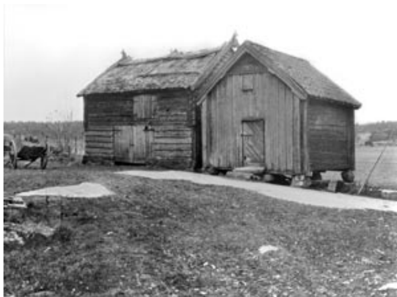
Fig. 7:6. Visthusbod och spannmålsbod av den typ som blev allt vanligare under 1800-talets första hälft i Bålsunda by, Hjälsås socken. De var ofta som här uppförda i två våningar, och friliggande vid sidan av mangården. Foto: F Bergman, Upplandsmuseet, RR 1104.
