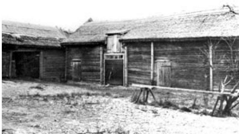
Fig. 7:5. Stall och portlider på gård i Balsunda by, Hjälsta socken i början av 1900-talet. Så här såg stallen ofta ut under 1800-talets andra hälft. Notera luckorna till skullen, som visar att skullarna nu allt mer börjat ersätta foderhusen för förvaring av foder. Foto: Bergman, Upplandsmuseet, RR1101,
