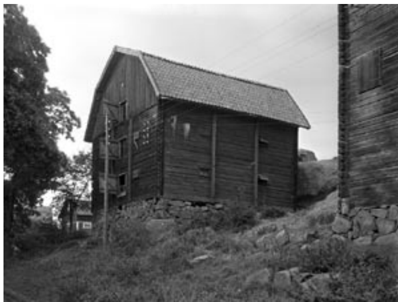
Fig. 5:3. Spannmålsboden på Høja säteri, Gryta socken. Så här såg de flesta spannmålsbodar ut på herrgårdarna under 1700- och 1800-talen. Denna är timrad i tre våningar under ett brutet tak, och uppförd i början av 1800-talet. Bakom spannmålsboden skymtar den kringbyggda ladugården. Till höger i bild en lada som uppfördes utanför ladugården i samband med att utrymmesbehovet ökade i slutet av 1700-talet. Jämför med fig. 5:8. Foto: Wallin 1928, Nordiska museet, Herrgårdsundersökningen, 210. K. h.
