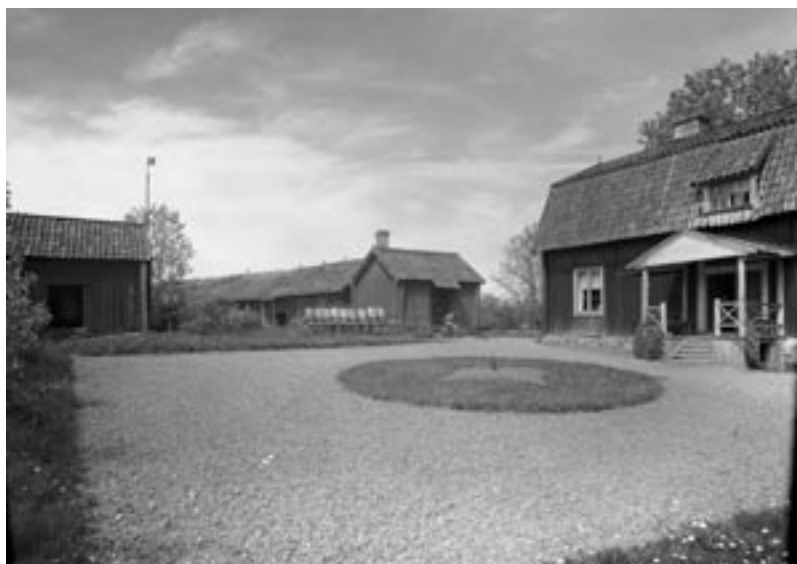
Fig. 6.3. Manbyggnad, mangård och del av ladugården på Holms kyrkoherdeboställe, Holms socken. Manbyggnaden på Holm uppfördes år 1780, och var av den typ som förekom på samtliga kyrkoherdeboställen; en byggnad i en våning med sexdelad planlösning under brutet tak. Bredvid manbyggnaden ligger spannmålsboden byggd år 1833 och visthusboden, uppförd omkring år 1770. Bakom dessa skymtar ladugården. Foto: Lindros 1927, Nordiska museet, Prästgårdsarkivet 164. V. w.
