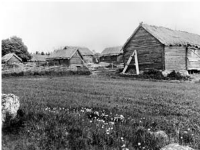
Fig 7:2. En typisk bondgård så som de ofta såg ut under 1700- och 1800-talen. Kveks by, Fröslunda socken, i början av 1900-talet. Närmast i bild ladugården med en stor lada, och bakom denna skymtar fähuset. Mitt emot ladan lög stallet som skilde ladugården från mangården. Av mangårdens byggnader syns endast spannmålsboden, och där bredvid skymtar taket till manbyggnaden. Samtliga byggnader var timrade under balmtak. Gården är sedan 1930-talet friluftsmuseum. Okänd fotograf, Upplandsmuseet, RR 892.
