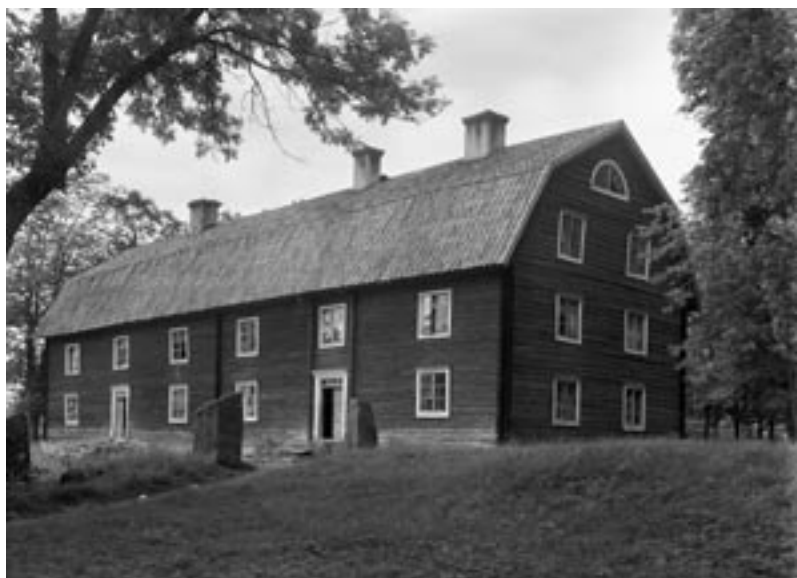
Fig. 5:4. Arbetarbostad på Höja säteri, Gryta socken. Arbetarbostaden uppfördes omkring år 1800 och innehöll sex lägenheter och några enkelrum. Arbetarbostäder av den här storleken var dock ovanliga vid den här tiden, utan uppfördes främst under 1800-talets sista decennier då animalieproduktionen blev allt viktigare. Byggnaden revs i början på 1940-talet. Foto: Wallin år 1928, Nordiska museet, herrgårdsundersökningen, 210. K. d.
