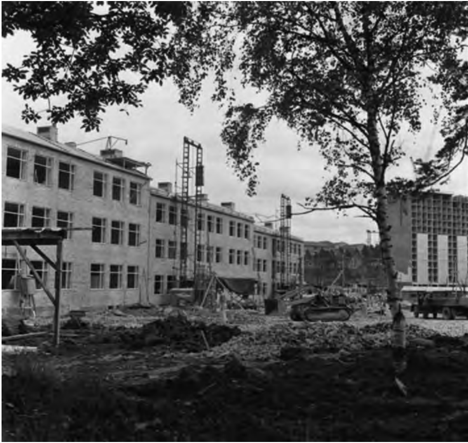
3: Hässelbygårdsskolan under uppbyggnad, 14 augusti 1957. Mellan 1947 och 1957 byggdes det 35 nya skolor i Stockholm. Foto: Herman Ronninger. Fotonummer SvD 30477. Stockholmskällan.
